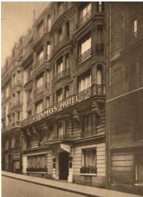
Ehem. Hôtel Cosmos, 14, rue Lentonnet, 75009 Paris (1934)
